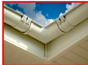
Каждый угол вывешивается на два дополнительных крюка, также дополнительные крюки устанавливаются на краю желобов в местах стыковки углов.
